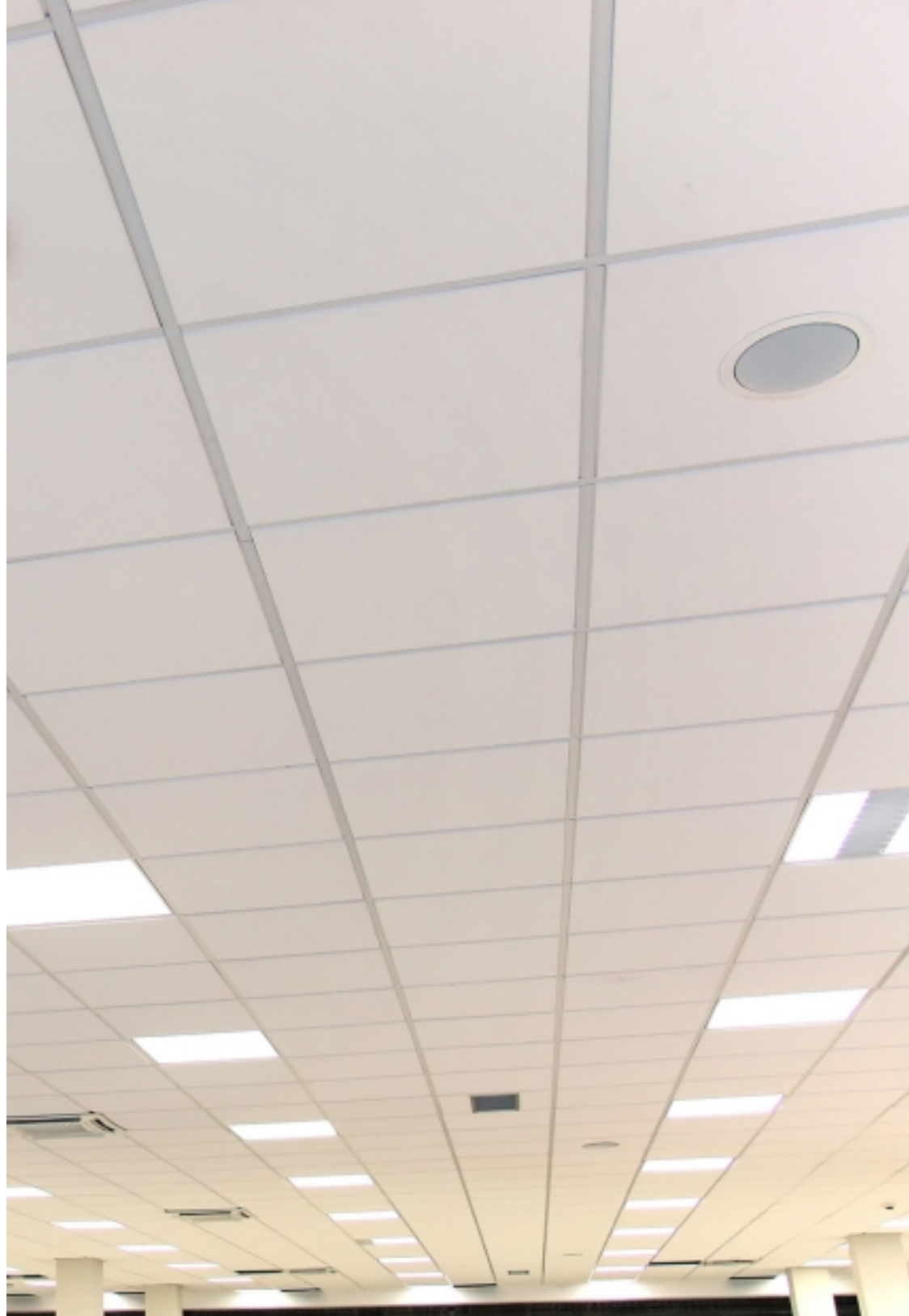
Undertak monteras på eller under innertaket. Det bidrar till rummets estetiska inramning, förbättrar ljudmiljön och kan dölja olika typer av installationer.
